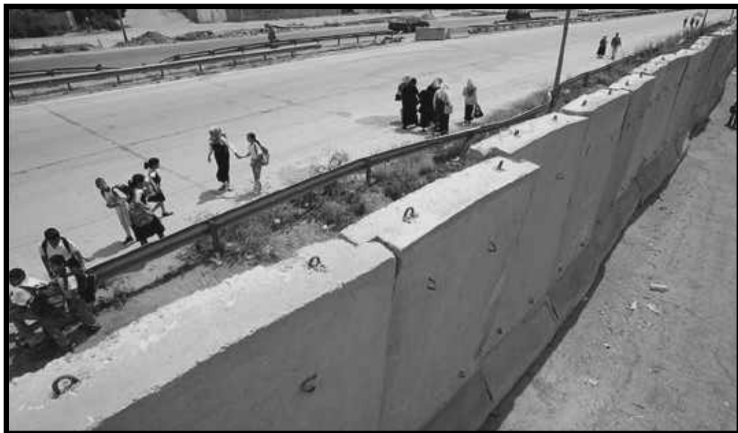
Irak: los barrios de Bagdad transformados en ghettos por los muros construidos por las tropas de ocupación angloyanquis
